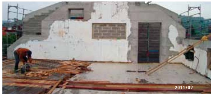
En parallèle avec la poursuite de la construction de l'annexe, enlèvement des anciennes toitures, coulage des dalles béton dans la partie rénovée et confection d'une ceinture béton de reprise des charges de la nouvelle toiture. Zeitgleich mit der Konstruktion des Anbaus werden die alten Dächer entfernt, die Betondecken des renovierten Teils vergossen und ein Ringanker zur Aufnahme der Dachlasten eingebaut.
