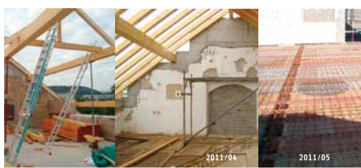
Pose des nouvelles charpentes. Renforcement des dalles planchers avec des dalles collaborantes en béton. Poursuite de la construction de l'annexe. Einbau des neuen Tragwerks; Verstärkung der Fußbodenplatten durch zusätzliche Betonplatten; Fertigstellung der Konstruktion des Anbaus.
