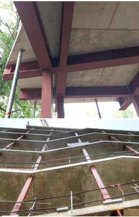
De gedeeltelijk stalen structuur maakte het mogelijk om van de intrinsieke kwaliteit van dit materiaal, d.w.z. minimale volumetrische impact voor maximale flexibiliteit, te profiteren. Zo werd mogelijk dankzij het staal: zeer dunne kolommen achter een dubbelwandige gevel en een ondersteuningssysteem op de begane grond voor de oversteek van de gevel op 5 niveaus.
